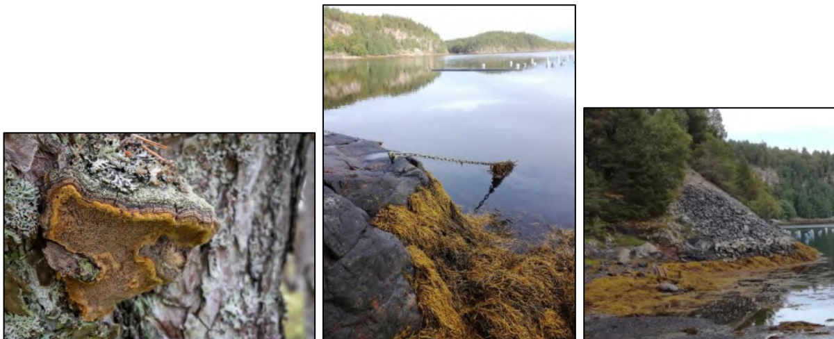
Furustokkjuke (NT), Landfeste til akvakulturanlegg, tipp ved steinbrudd.
